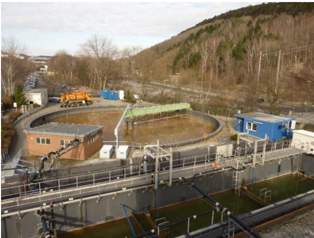
Abbildung 16: Zentrale Abwasserbehandlungsanlage (ZABA). 2
