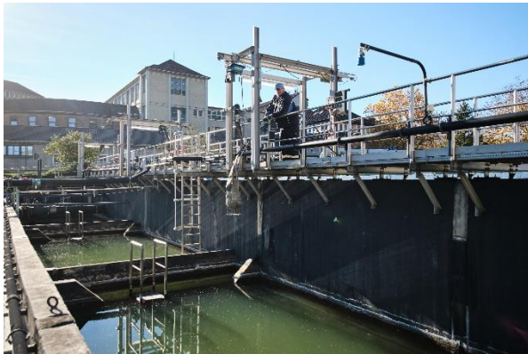
Abbildung 16: Zentrale Abwasserbehandlungsanlage (ZABA)
